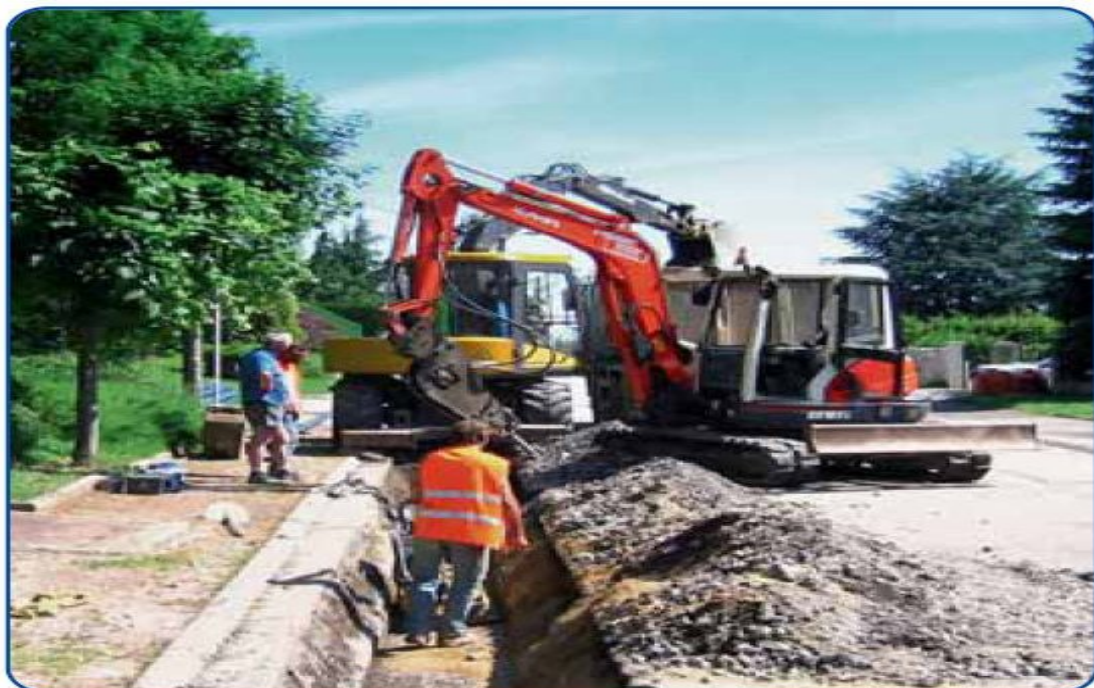
Figure VII.1: Pose de conduite au bord de la route.
