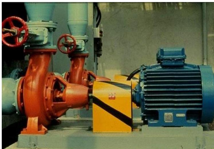
Figure. V.1. Pompe centrifuge à axe horizontale avec vannes d'isolement.
