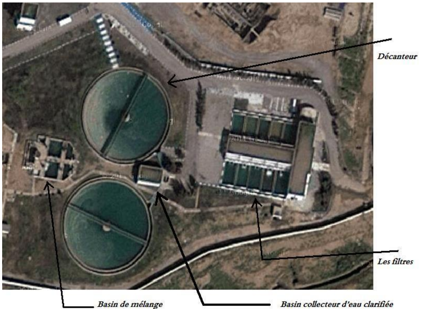
Figure IV.3- Ouvrages de décantation, filtration, mélange et collecteur
