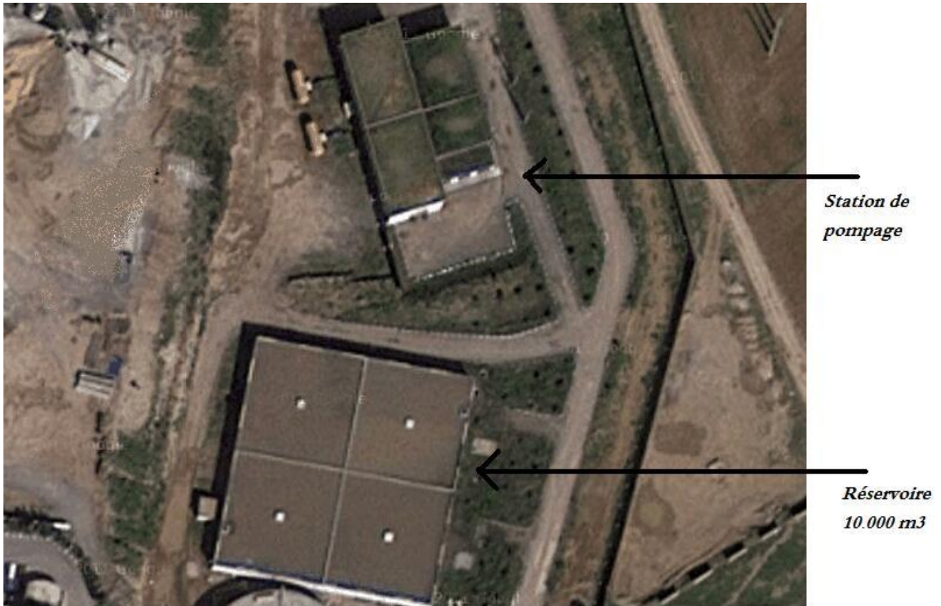
Figure IV.4- Le réservoir d'eau traitée et la station de pompage
