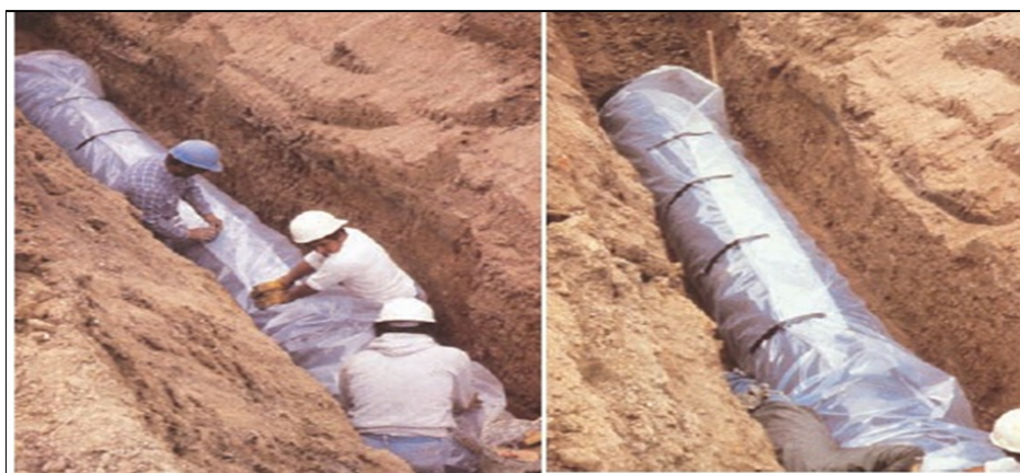
Figure N° VI.13: Installations de tuyaux recouverts d'une protection en polyéthylène.
