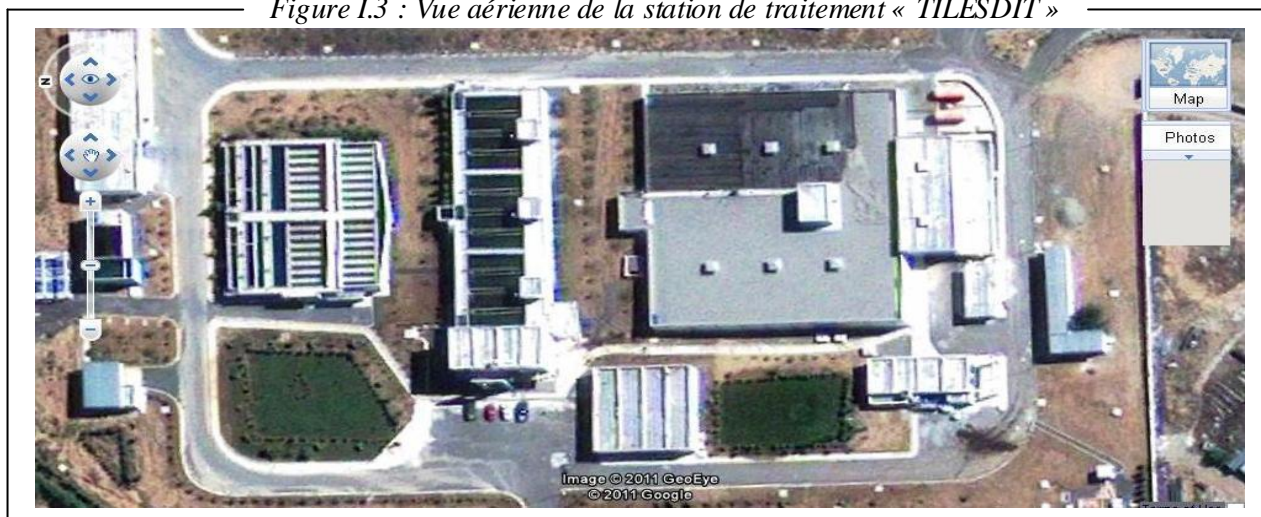
Figure I.3 : Vue aérienne de la station de traitement « TILES DIT »
