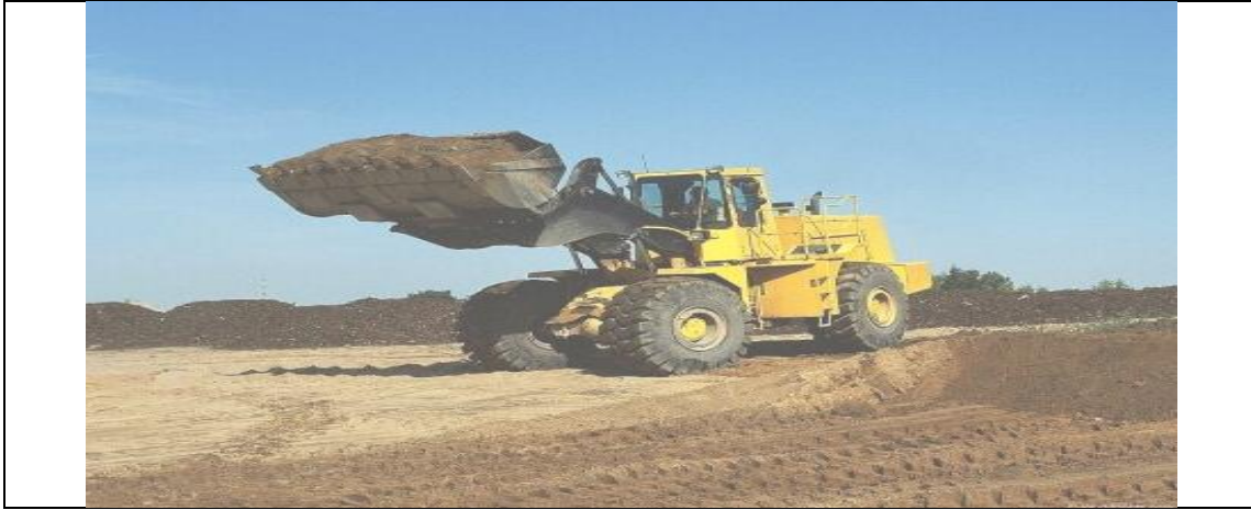
Figure VII.7 : Chargeur sur chantier.
