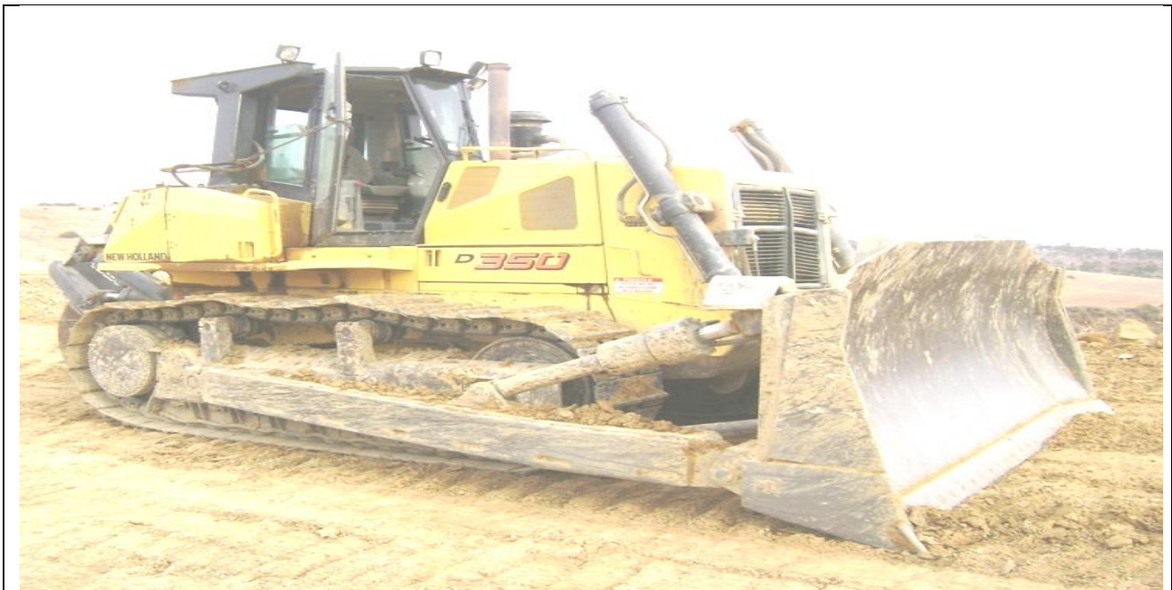
Figure VII.4 : Dozer sur chantier.
