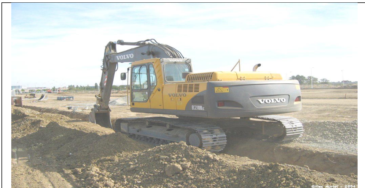
Figure VII.5 : Une pelle hydraulique sur chantier.
