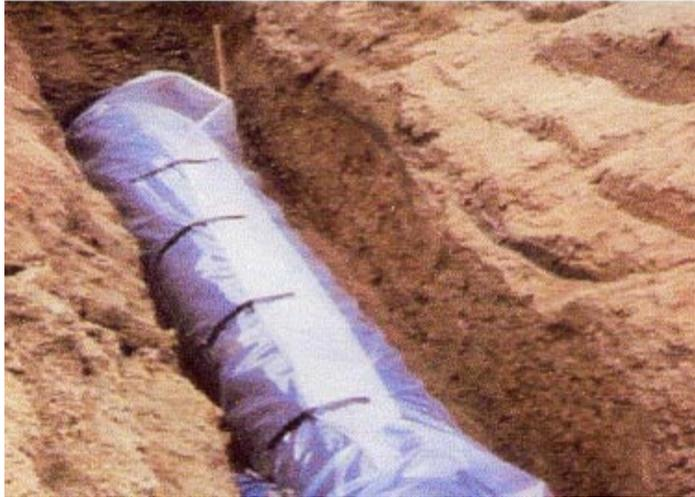
Figure VI-3: Protection contre la corrosion extérieure avec revêtement en polyéthylène
