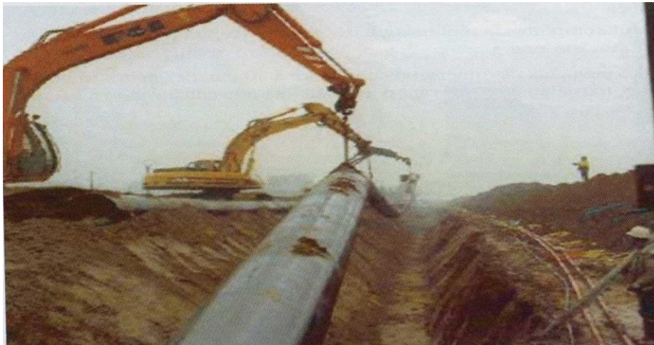
Figure VIII.4 : Pose des conduites en PEHD dans les tranchées
