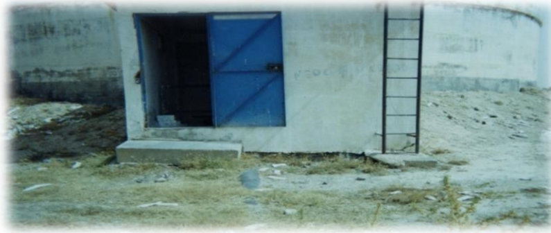
Figure I.4 : Réservoir de 1000m 3
