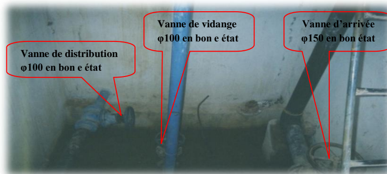
Figure I.8 : Chambre des vannes du réservoir 250 m 3
