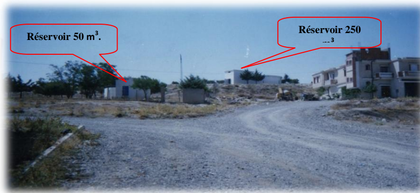
Figure I.3 : Vue générale des réservoirs 250 m 3 et 50 m 3
