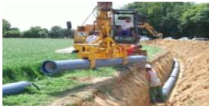
Figure VIII.1.a: Pose de conduite dans un terrain ordinaire.
