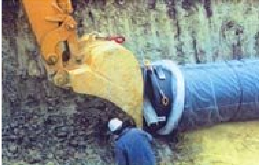
Figure VIII.1.c: Pose de conduites dans un terrain agressif.
