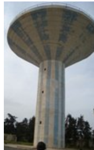
Figure N° IV-01 le réservoir existant
