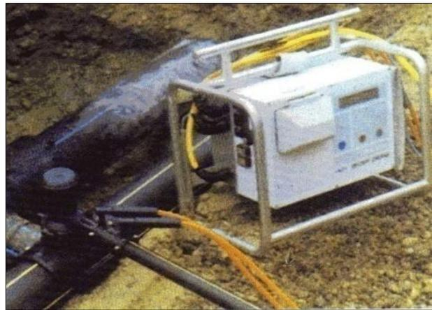
Figure IV.2 : Accessoires de raccordement d'électro soudage.
