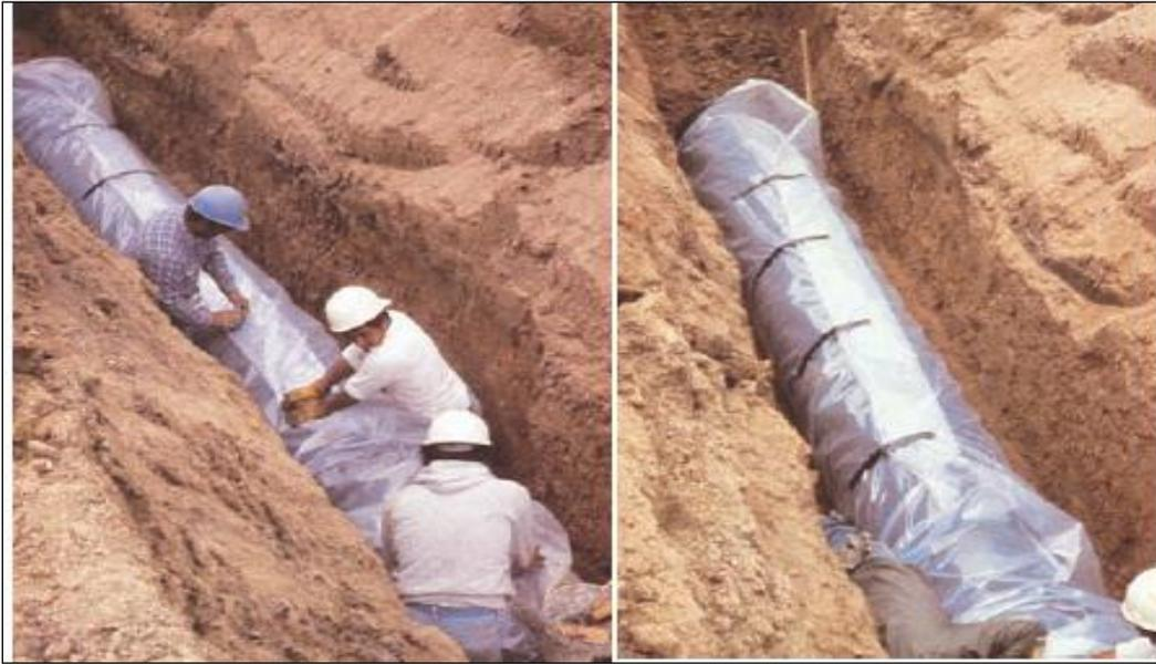
Figure VI.4 : Protection contre la corrosion extérieure avec revêtement en polyéthylène
