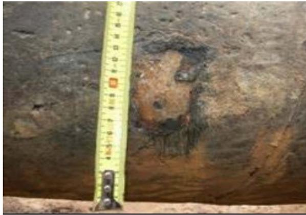
*Figure 3 : revêtement blessé sans aucune trace de corrosion après plusieurs années*
