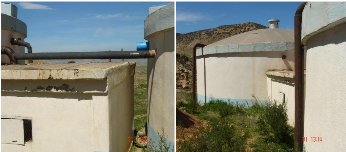
**Figure II.10** : Etat actuel des réservoirs jumelés (2X500m<sup>3</sup>) d'Ouled Makhlof.
