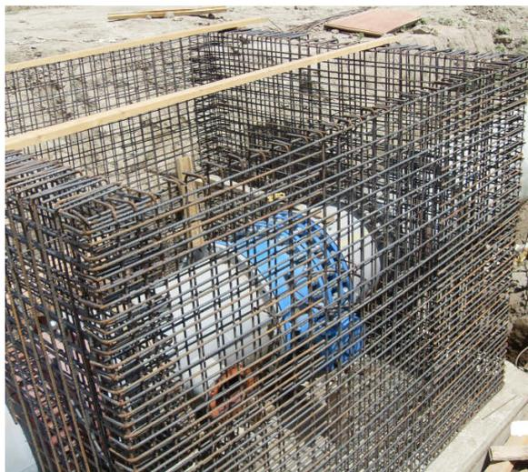
*Figure VII-7 : Construction d'un regard*
