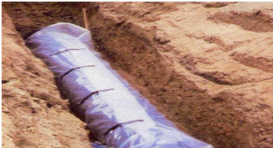
**Figure (VII-5) :** Installations de tuyaux recouverts d'une protection en polyéthylène.
