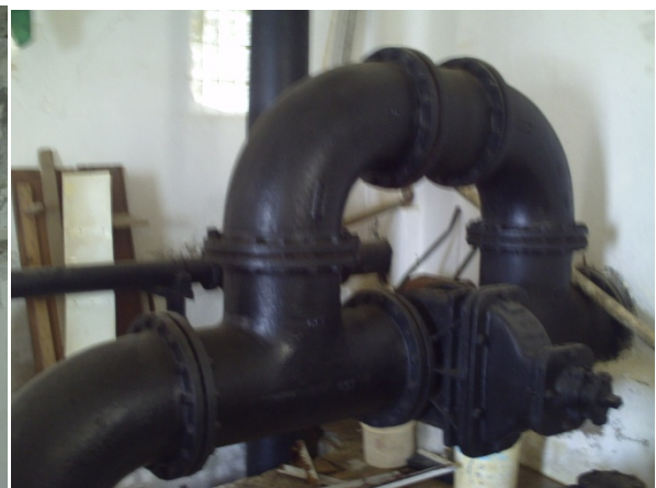
Figure III.5.9: By pass de la Conduite de départ.
