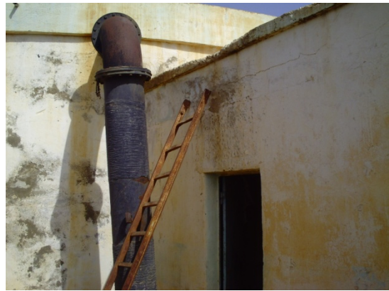
Figure III.5.2: Conduite de refoulement
