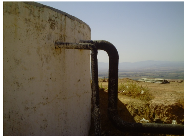
Figure IV.5.16: Réservoir Oued RIHQNE3. Figure IV.5.17: Conduites d'arrivé et du trop plein.
