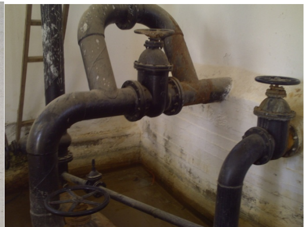
Figure III.5.10: Réservoir SIDI M'HAMED 2. Figure III.5.11: Conduite de départ et du vidange.
