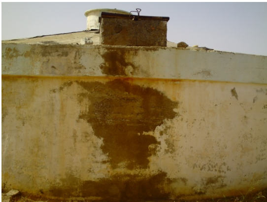
Figure III.5.1: Réservoir Sidi MEKHFI
