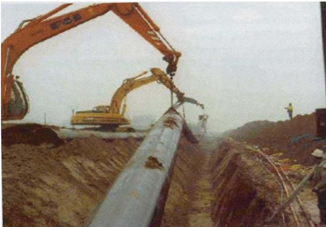
Figure VII-4 : pose des conduites en PE dans les tranchées
