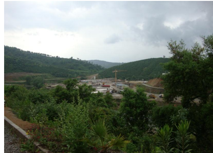
Photo.8. le chantier à l'aval du barrage de Boussiaba
