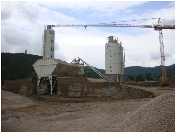
Photo.7. moyens matériels sur le chantier
