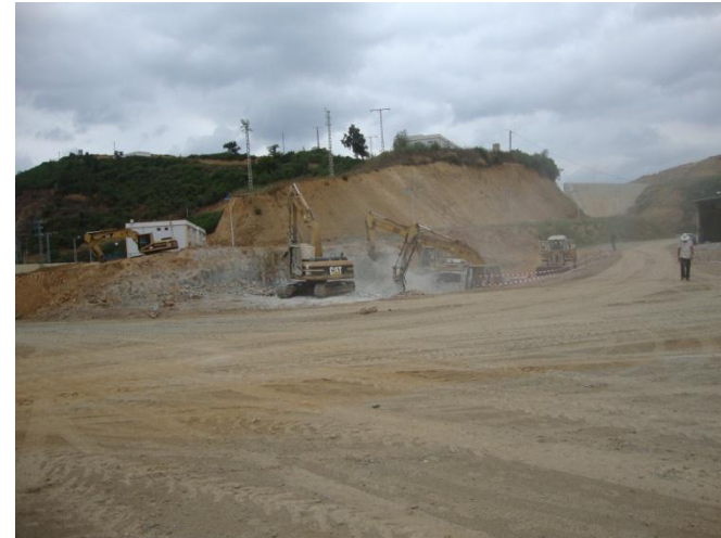
Photo.6. Aménagement de la station de pompage
