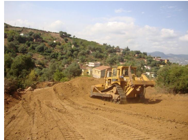
Photo.2. Prise lors des travaux de décapage
