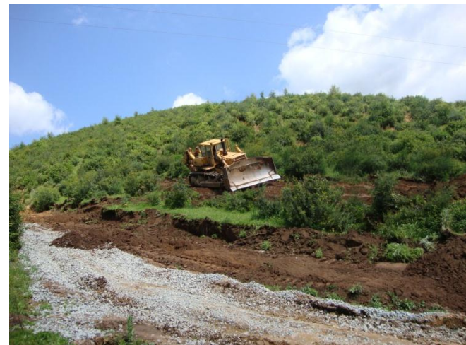
Photo.4. Prise lors des travaux de terrassement
