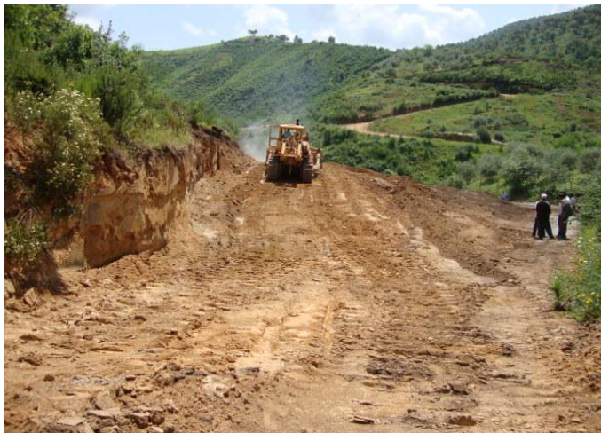
Photo.3. Prise lors des travaux de terrassement
