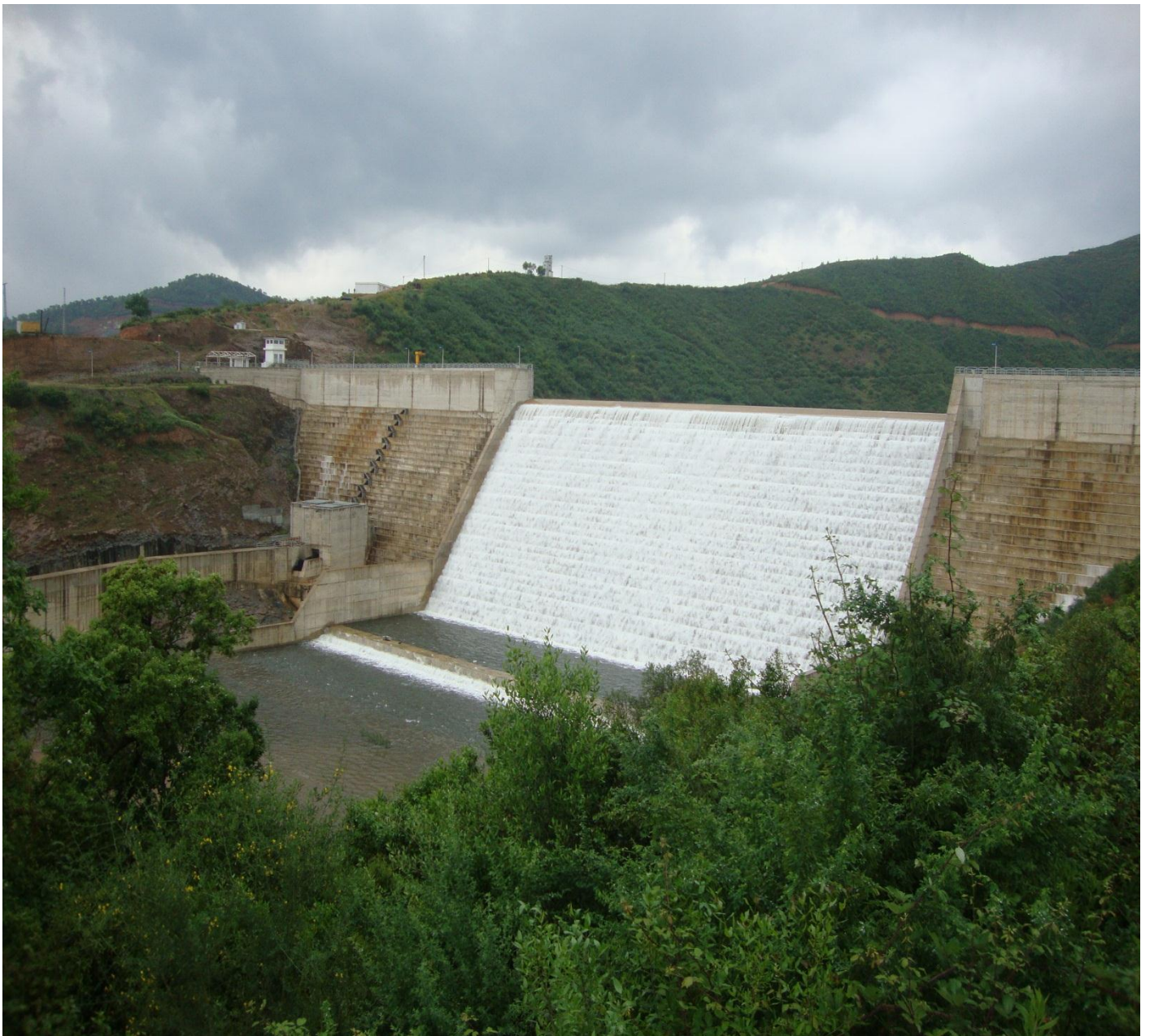
Figure I-5 : Photo du barrage de Boussiaba
