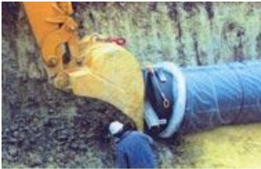
Figure VI.5: Pose de conduites dans un terrain agressif.
