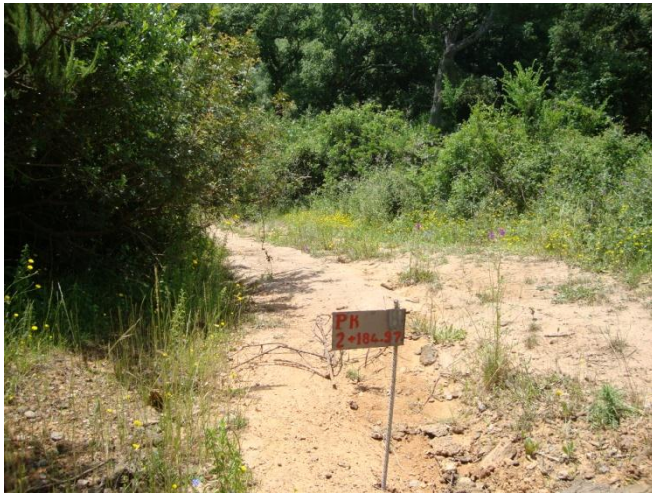
Photo.1. Prise lors des travaux de piquetage
