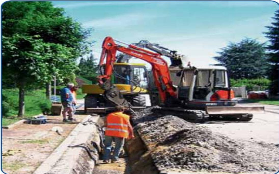
**Figure V.1:** Pose de conduite au bord de la route.
