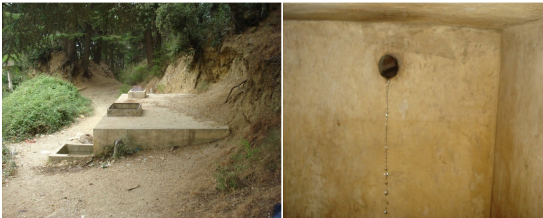
Figure II.8 : Bassin de collecte n°1
