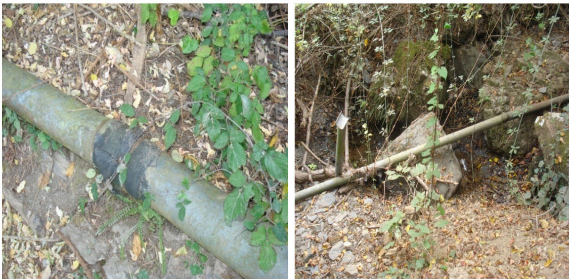
Figure III.1 : Conduites détériorés
