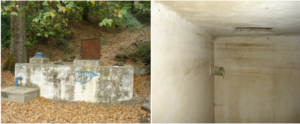
Figure II.9 : Bassin de collecte de Ain el Houta
