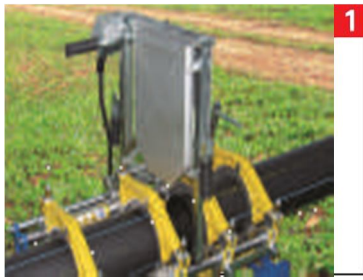
Mise en place de la plaque chauffante
