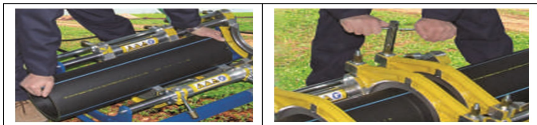
Figure VII.26: La façon de positionnement de la canalisation
