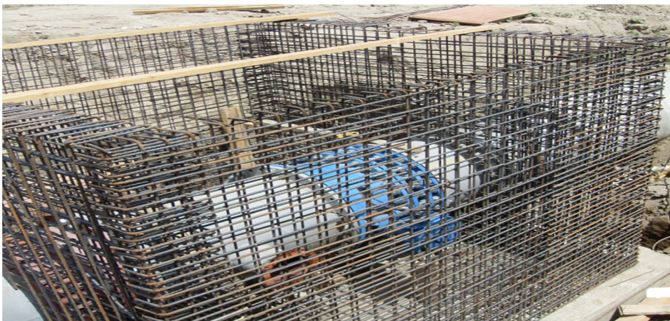
Figure VII.7 : Construction d'un regard
