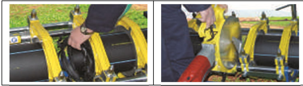
Figure VII.27: La façon de rabotage
