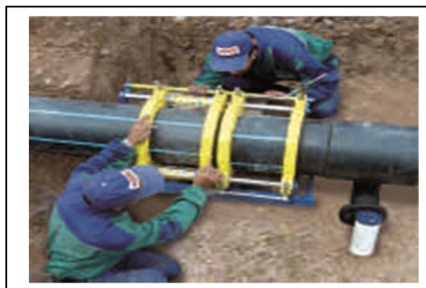
Figure VII.23 : Soudage bout à bout
