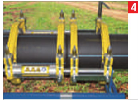
Soudage et refroidissement
