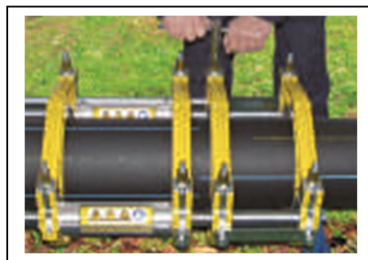
Figure VII.28 : La façon de centrage et alignement
