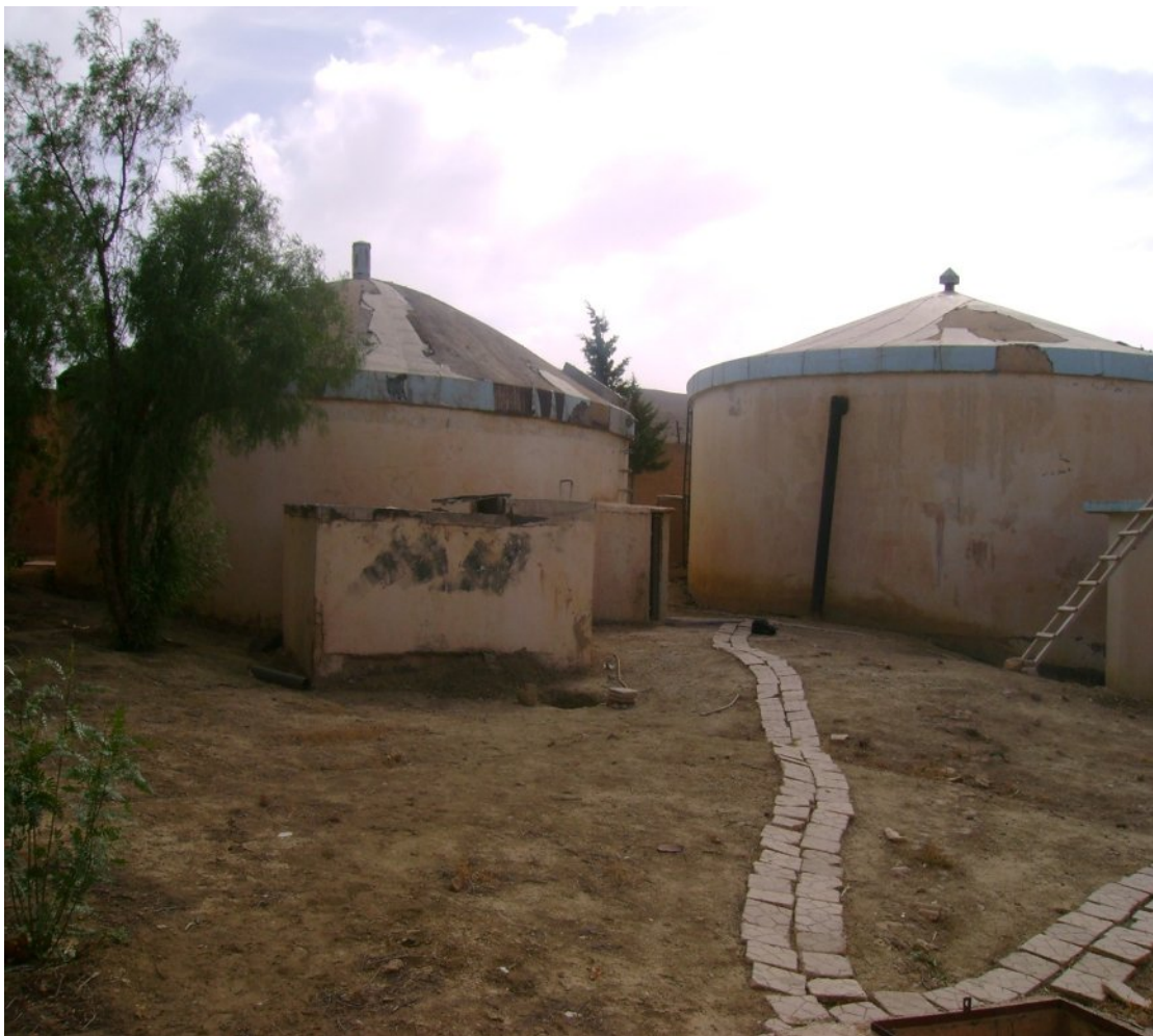
Figure N°2 : site des réservoirs
