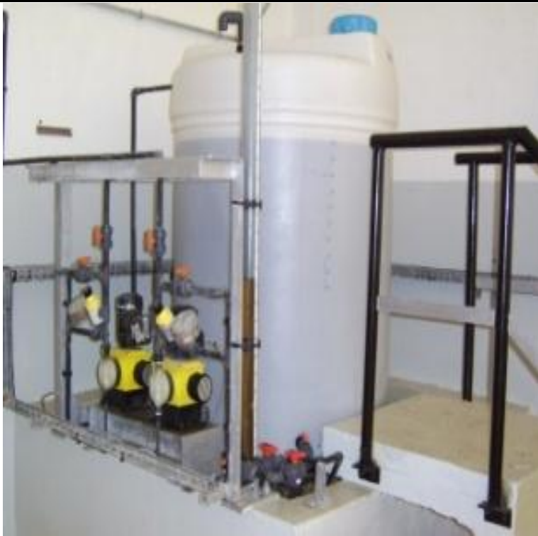
Figure V-3 : Schéma du réservoir d'ajout d'antiscalant.
