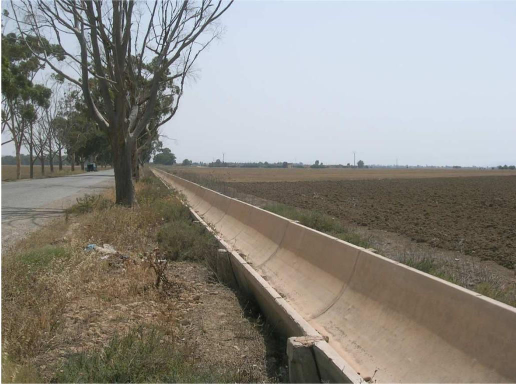
Canal principal du système d'irrigation (grand périmètre d'irrigation de la Mina).
