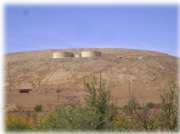
Figure 1.1 : Réservoir jumelé de volume 2 \times 1500 \text{ m}^3
