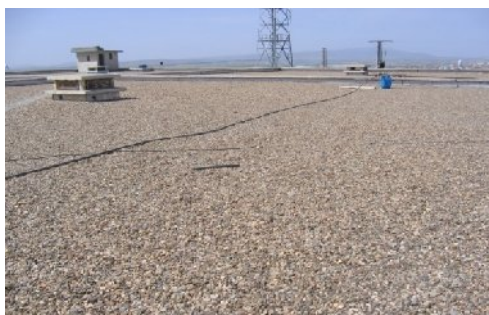
Figure 1.5 Le toit du R 10000 m 3 . Bon état.
