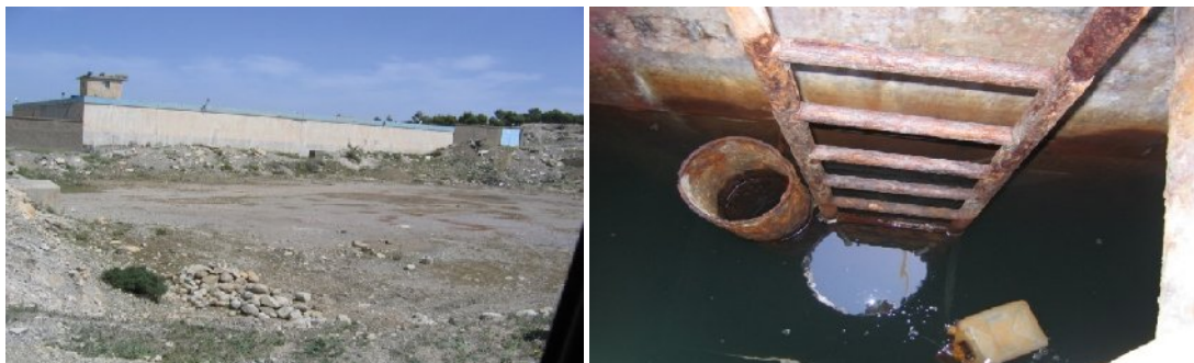
Figure I.3 Vue extérieur du R 10000 m 3 N°1. Figure I.4 Vue à l'intérieur du R X 10000 m 3 N°2.
