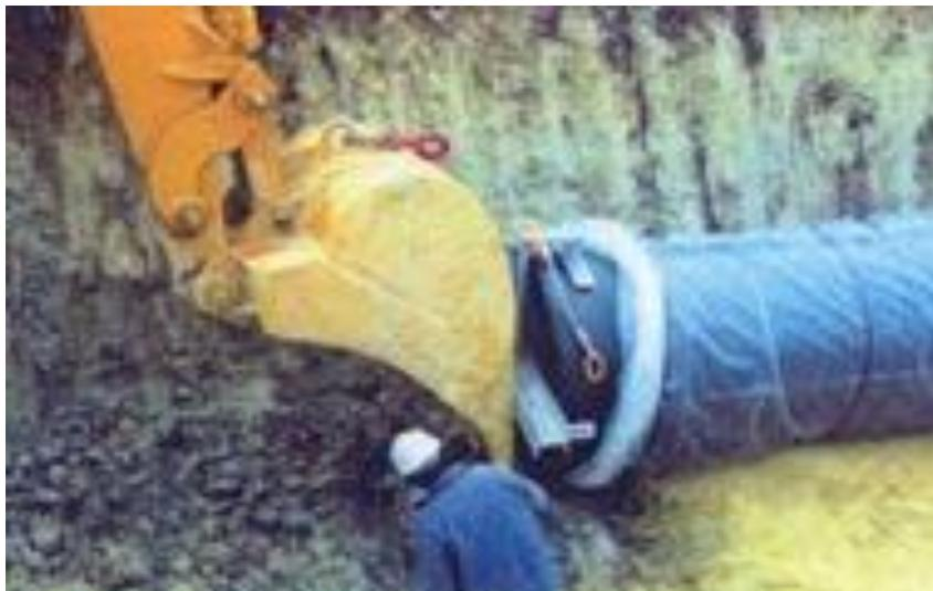
**Figure VI.3: Pose de conduites dans un terrain agressif.**
