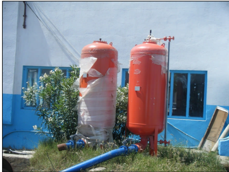
Figure VI-6: installation du réservoir d'air
