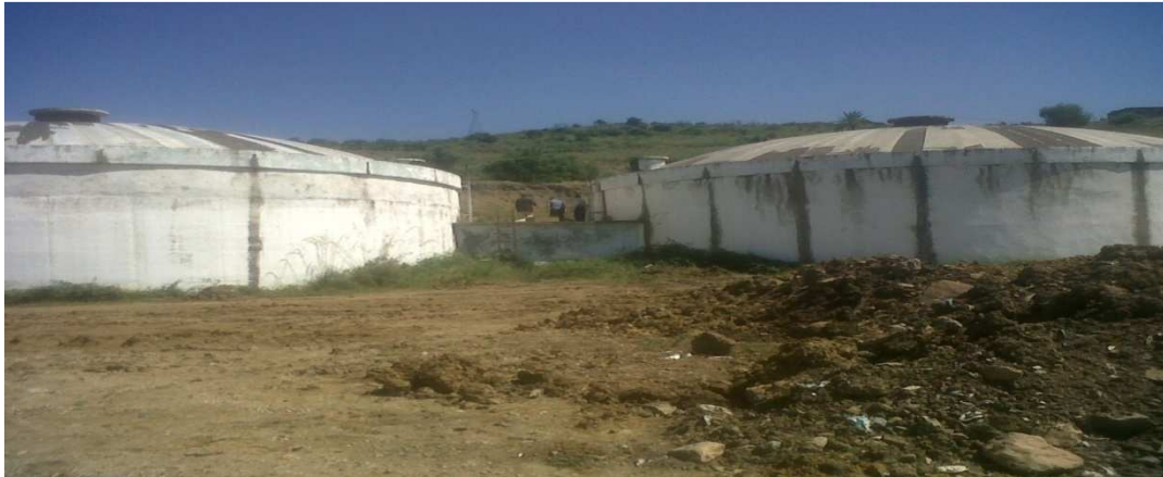
Figure 3.03 : Vue du réservoir semi enterré de volume 2 \times 1500 \text{ m}^3 .
