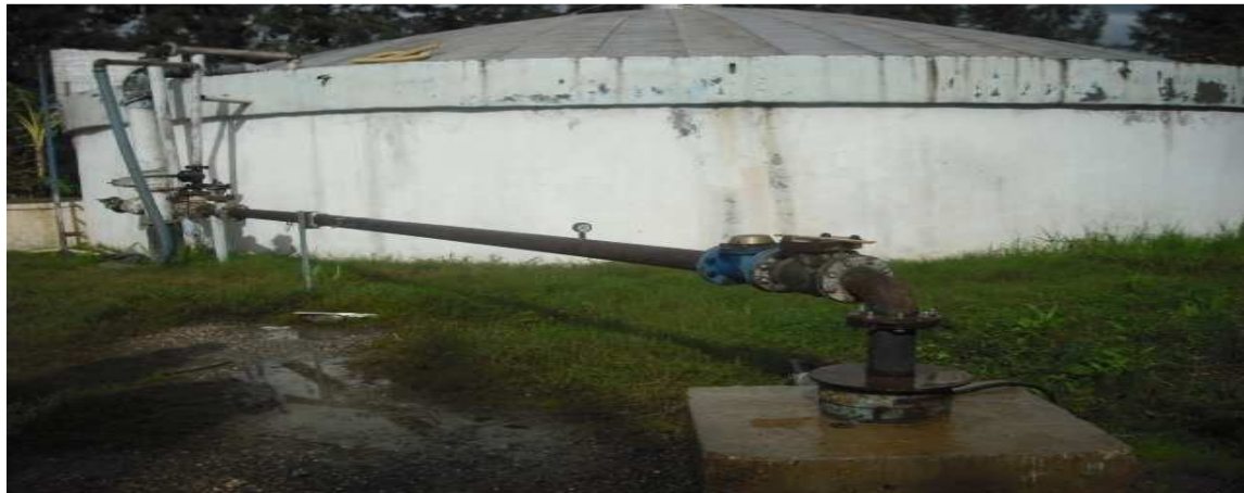
Figure 3.01 : Vue du réservoir semi enterré de volume 500 m 3 .
