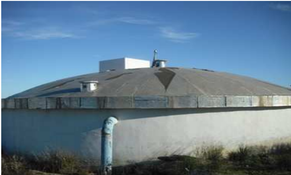
Figure 3.02 : Vue du réservoir semi enterré de volume 1000 m 3 .
