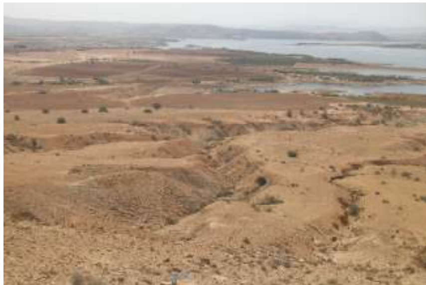
Photos illustrant l'effet de l'érosion hydrique au niveau du barrage SMBA (Clichés : Hallouz, F., 2011)
