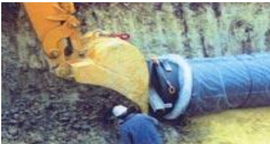
Figure VII-5: Pose de conduites dans un terrain agressif.
