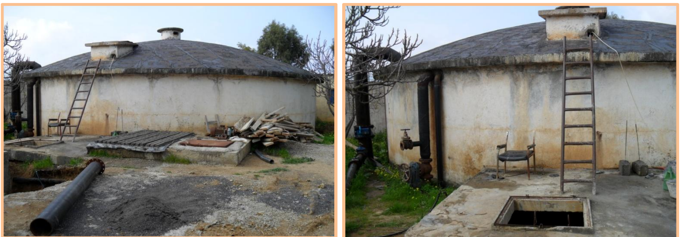
Figure 1-4 : Vue générale du réservoir R2 500m 3
