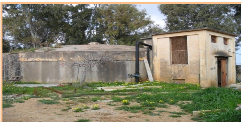
Figure 1-2 : Vue générale du réservoir R1 500m 3
