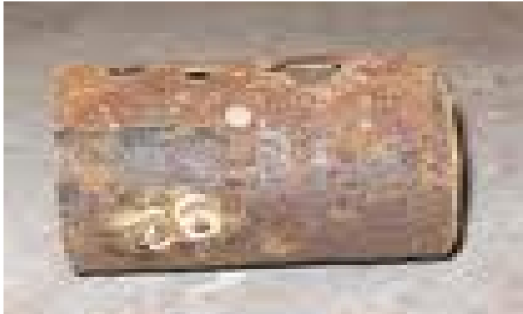
Photo IV.1 : Corrosion externe dans une conduite
