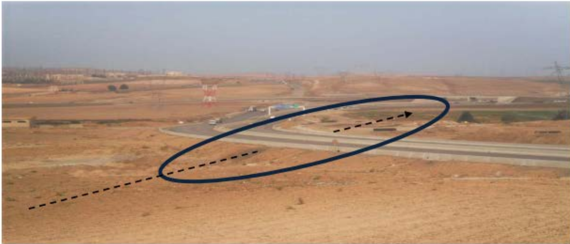
Photo II.1 : Traversée de l'autoroute
