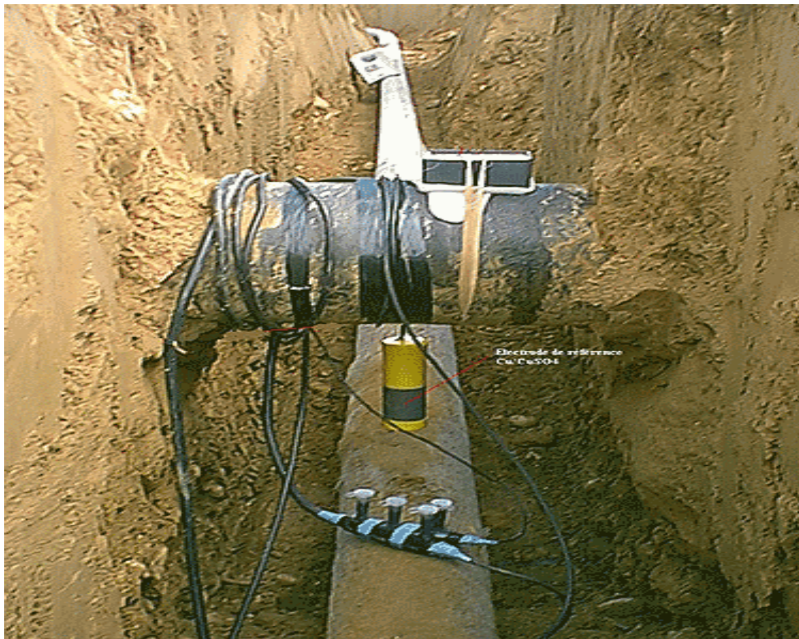
Photo IV.3: Schéma montre le dispositif de la protection cathodique
