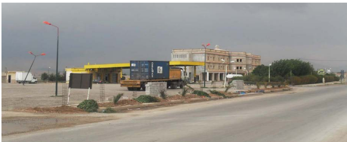
Photo II.4 : Divers constructions au niveau de la ville d'Ouled Hamla
