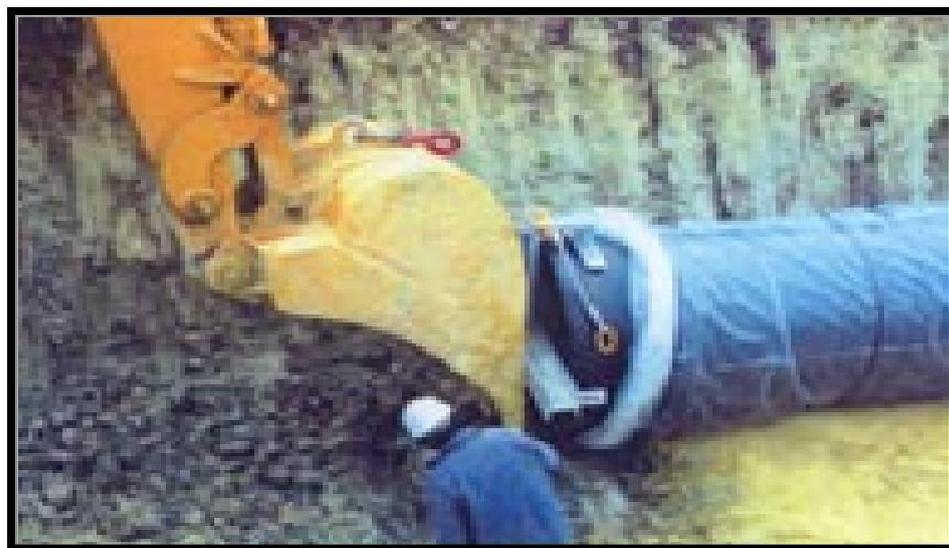
**Figure VII-2:** *Pose de conduites dans un terrain agressif.*
