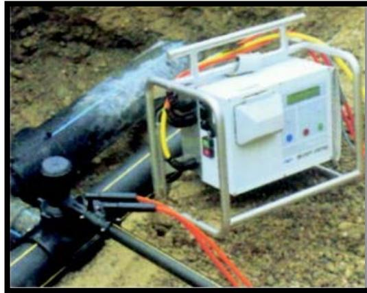
**Figure VII-11** : *les raccords électrosoudables.*
