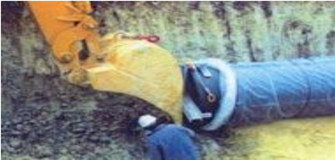
Figure VII.2: Pose de conduites dans un terrain agressif.
