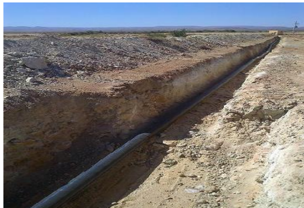
Figure VI.1: Pose de la conduite a la ville de Tadmout
