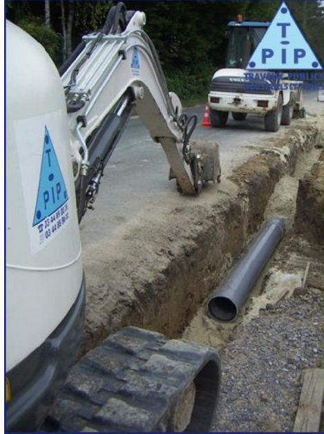
Figure VI.1.1: Pose de conduite dans un terrain ordinaire.
