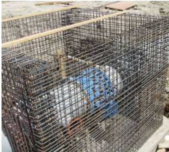
Figure VIII-1 : Construction d'un regard.
