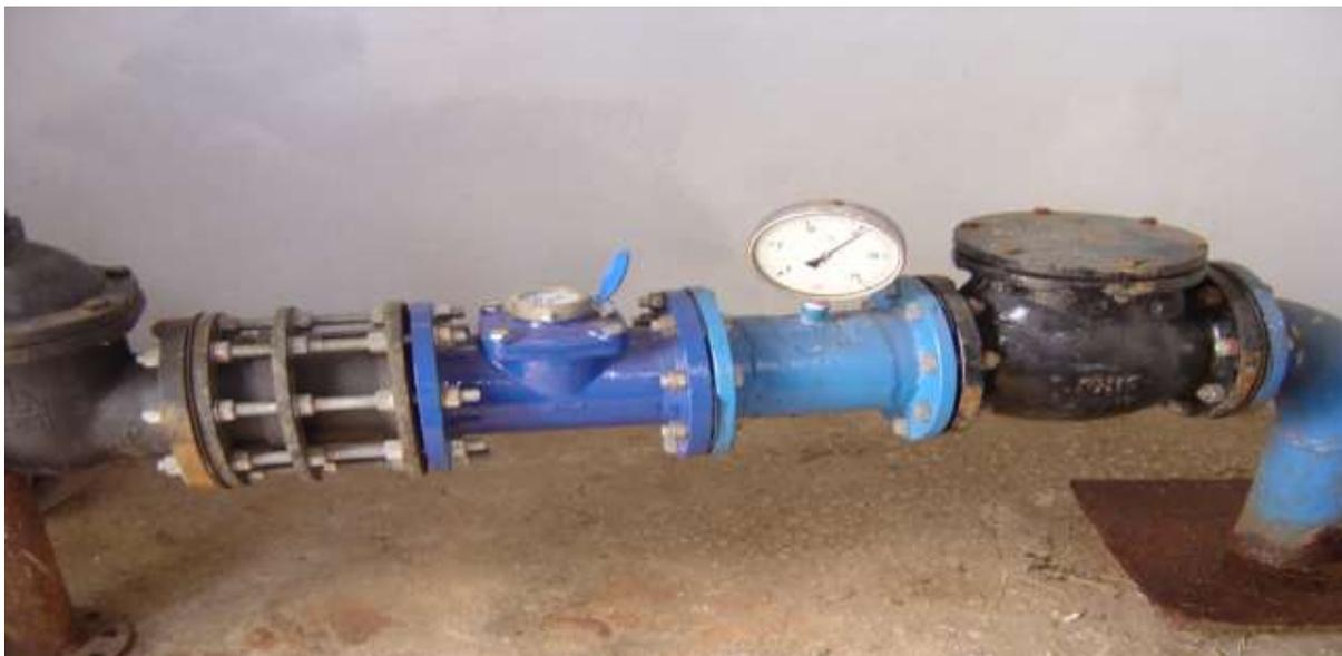
Figure V.5 : Les équipements hydrauliques de forage.
