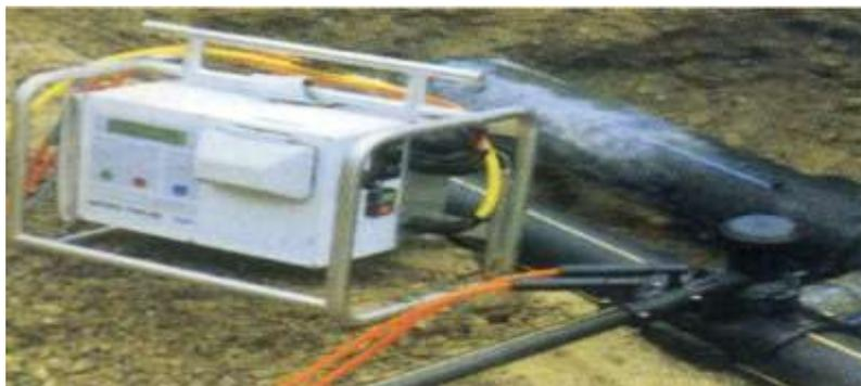
Figure VII.12 : Raccordement par accessoires électro-soudables.
