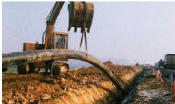
Figure 6.10: représente la pose en tranché
