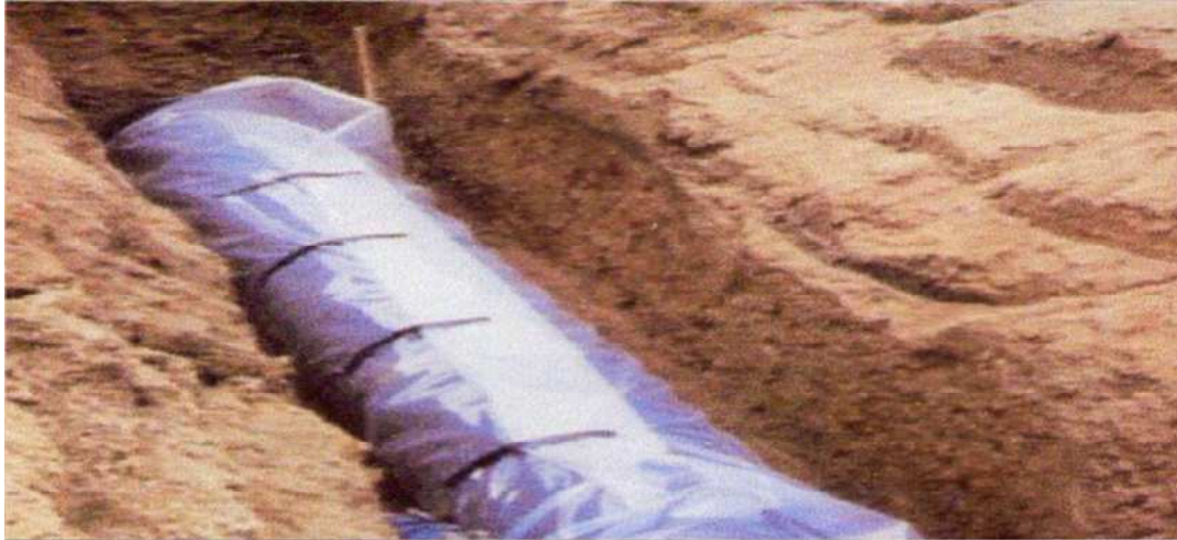
Figure VI.4: Installations de tuyaux recouverts d'une protection en polyéthylène
