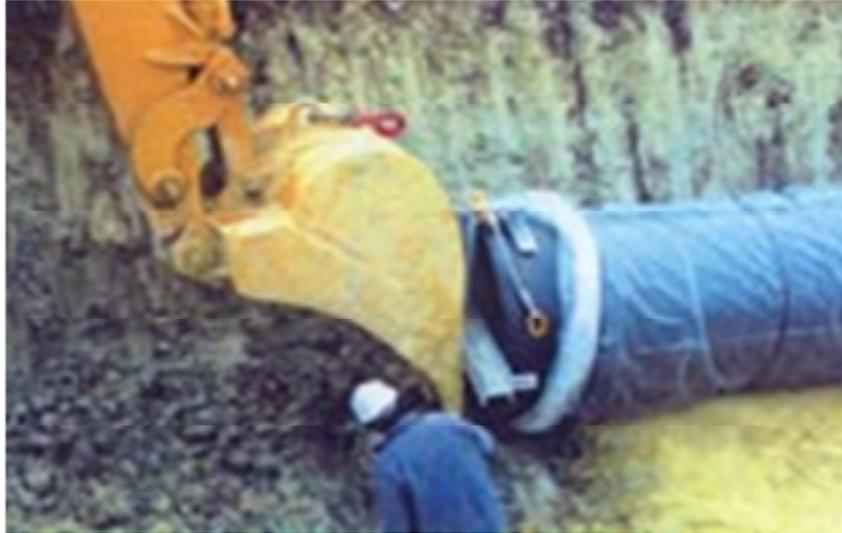
**Figure VI.2** Pose de conduites dans un terrain agressif.
