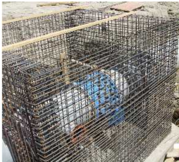
Figure VII .7 : Construction d'un regard
