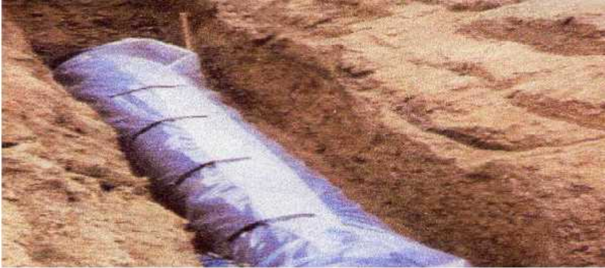
Figure VI.7 : Installations de tuyaux recouverts d'une protection en polyéthylène.
