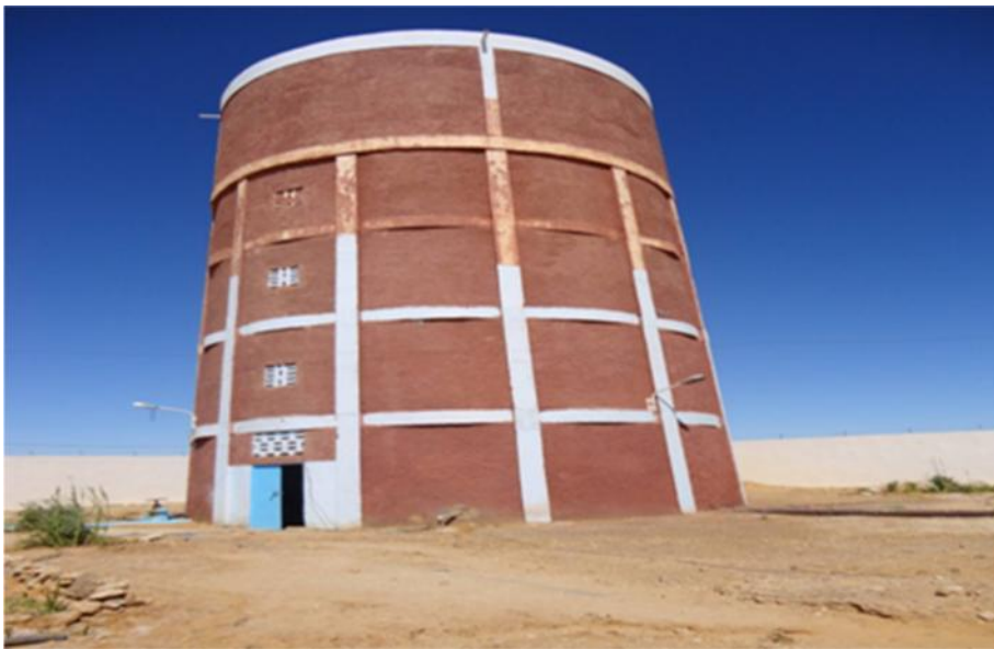
Fig I.7. Château d'eau 01 Charouine
