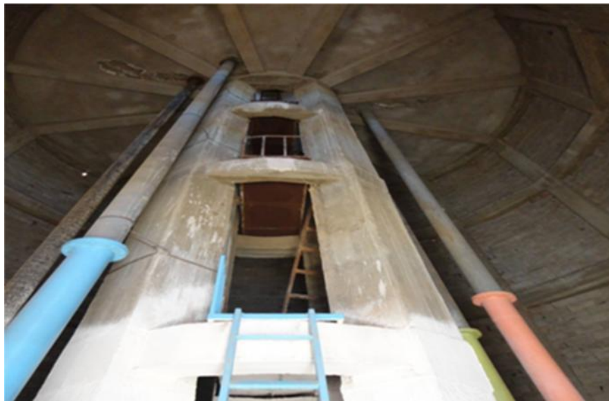
Fig I.8. Vue de l'intérieur du château 01
