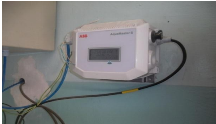
Figure III- 26 : Débitmètre à ultra son de refoulement
