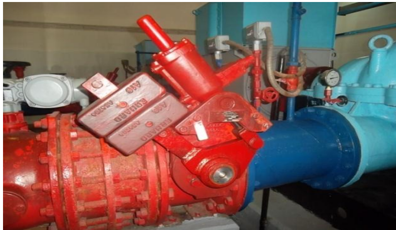
Figure III-13 : Clapet anti retour de refoulement
