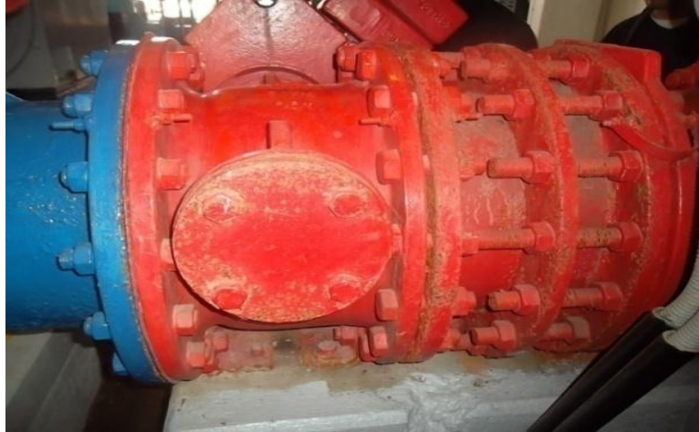
Figure III-12 : Joint de démontage.
