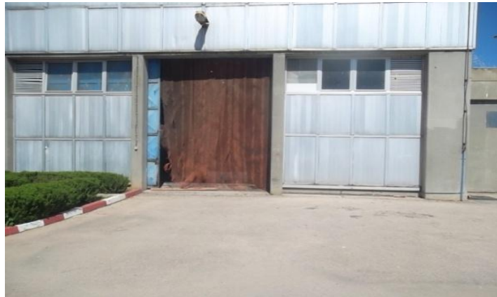
Figure III-29 : Extérieur du bâtiment de la station de pompage
