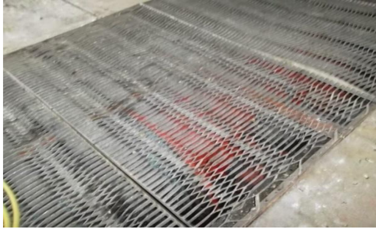
Figure III-27: Grilles de passage de collecteur d'aspiration
