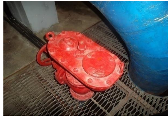
Figure III-7 : Soupape de décharge
