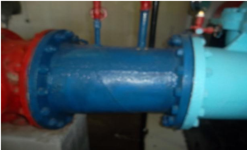
Figure III-9 : Divergent de conduite de refoulement.
