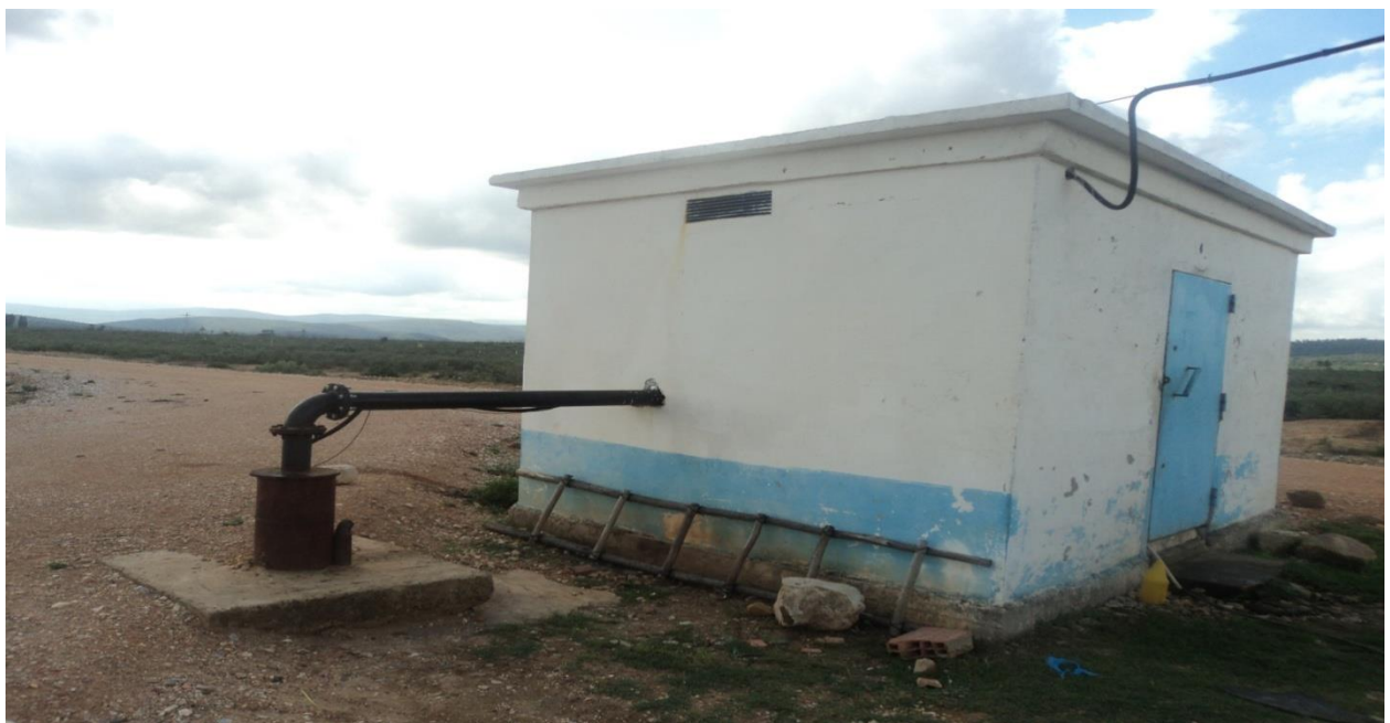
Figure III.24: Vu générale du forage U5.
