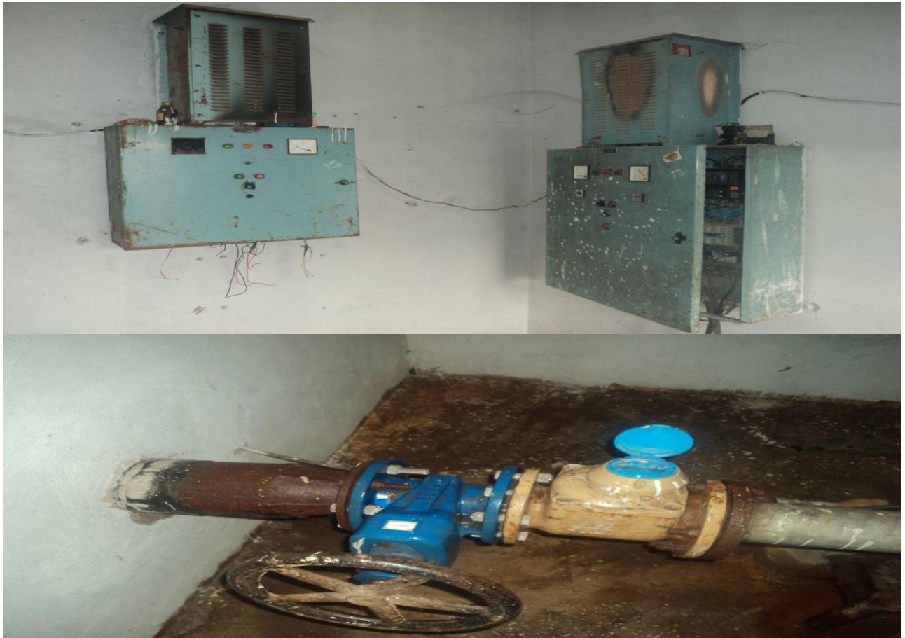
Figure III.5 : L'état des déferents accessoires dans la chambre de commande du forage F1.
