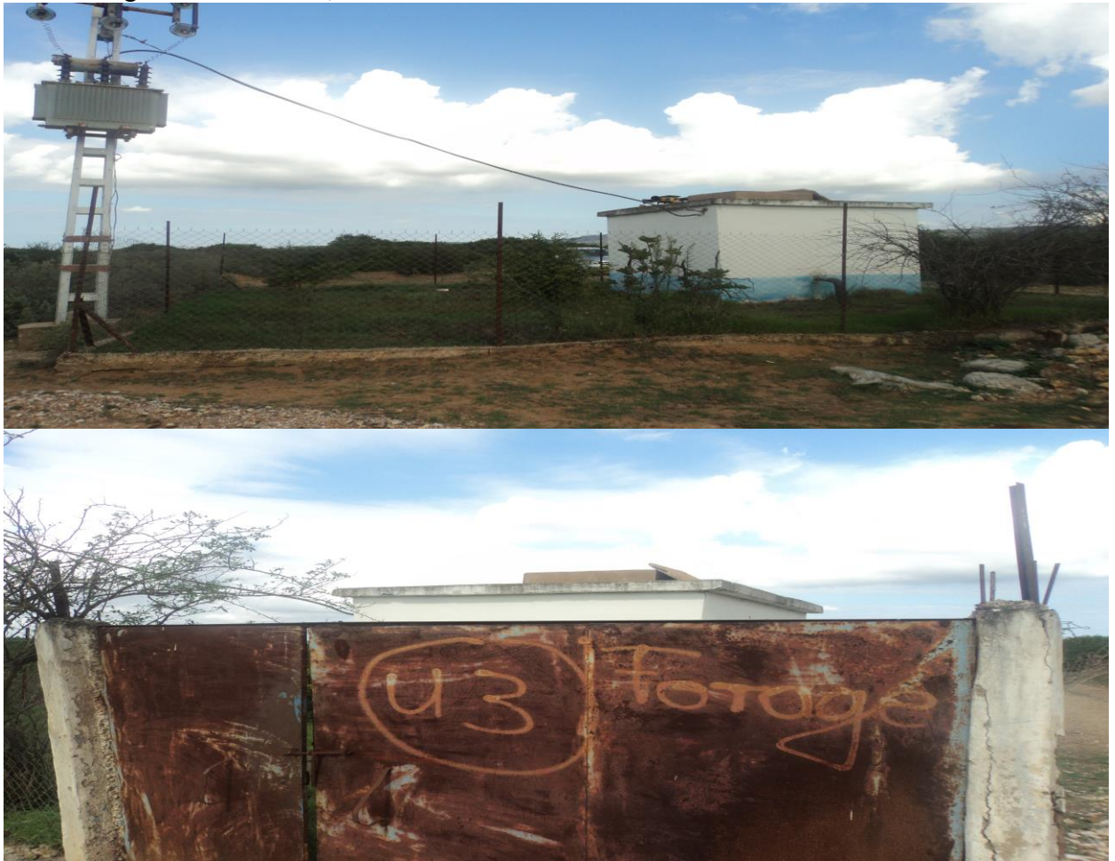
Figure III.19: Vu générale du forage U3.
