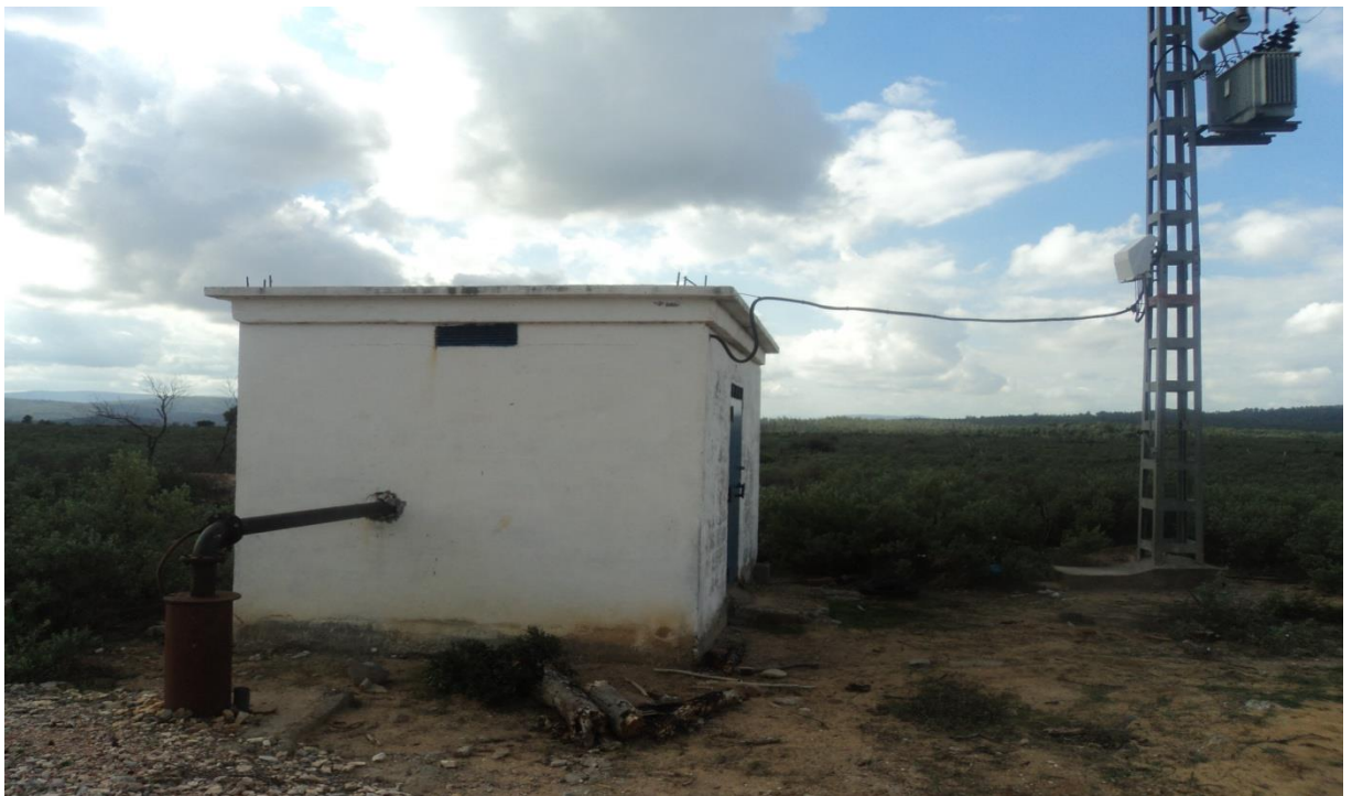
Figure III.28 : Vue générale du forage U6.
