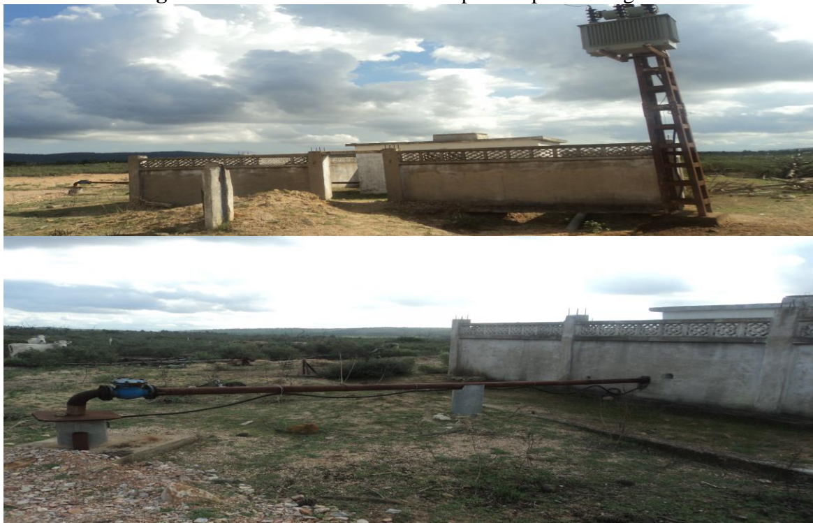
Figure III.16: Vue générale du forage U2.
