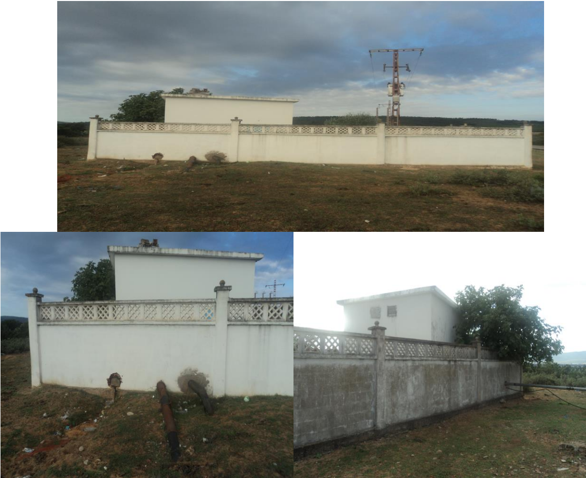
Figure III.3: Vue générale du forage F1.
