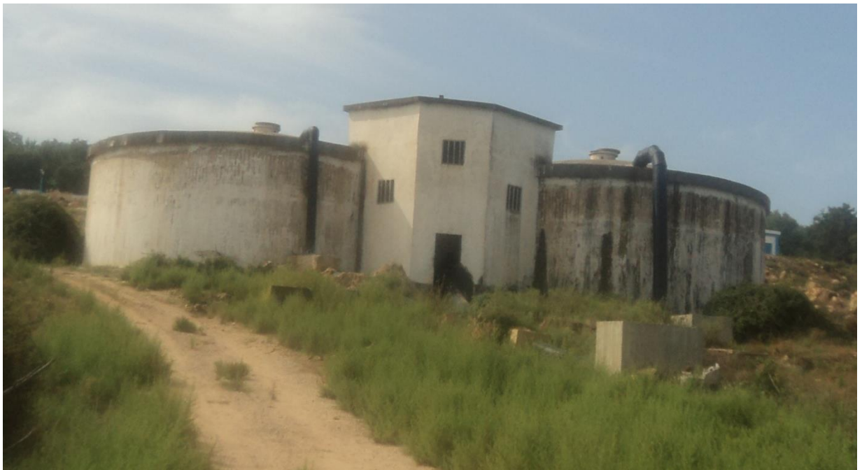
Figure III.37: Vu générale des réservoirs jumelés.
