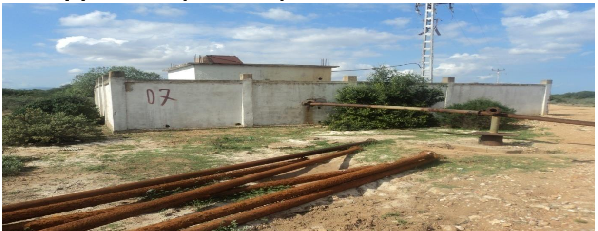
Figure III.20: Vu générale du forage U4.
