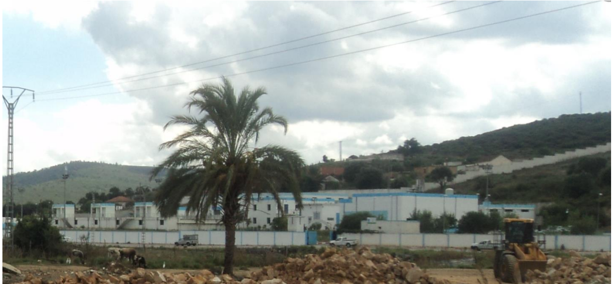
Figure III.30 : Vu générale de la station de traitement.
