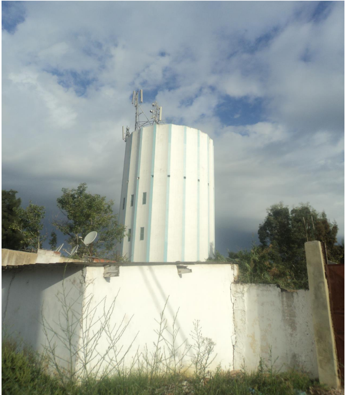
Figure III.41: Vue générale du réservoir 750m 3 .
