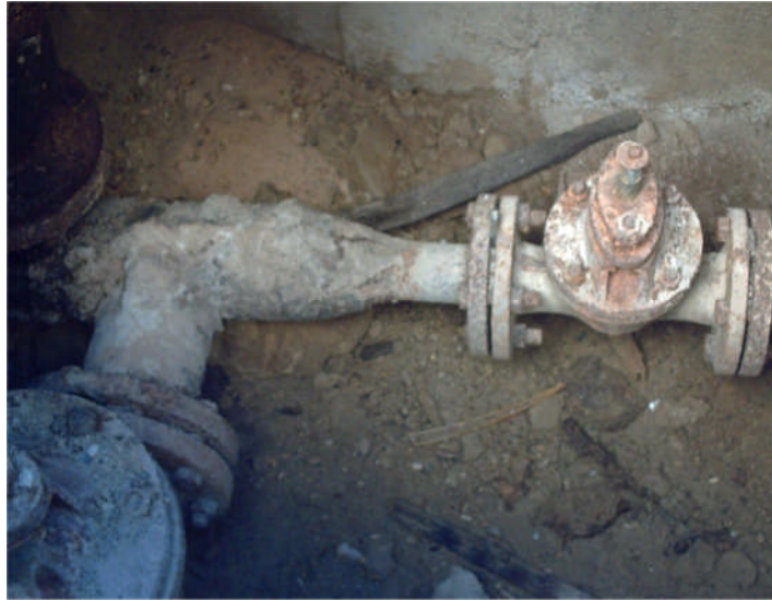
Figure3-6 : Vanne raccord vétuste
