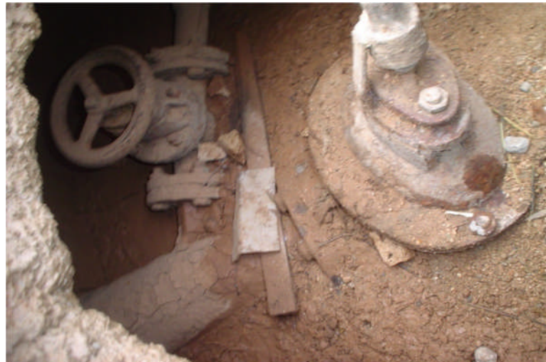
Fig3-7 : Vanne et conduite vétuste
