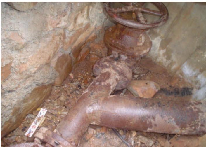
Fig3-7 : Vanne et conduite vétuste
