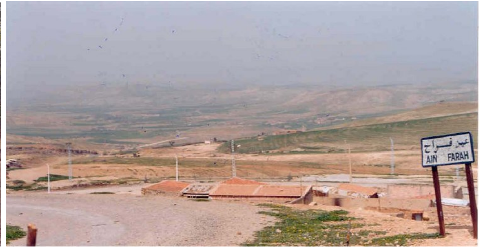
Figure I.4 : Photo de Réservoir Ain ferrah vers station de traitement.
