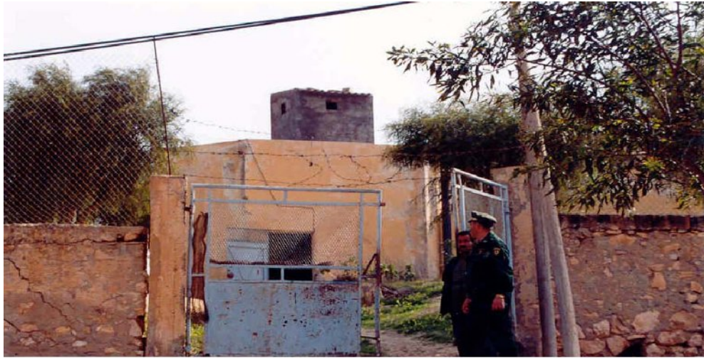
Figure I.3: Photo de Réservoir Oued El Abtal.
