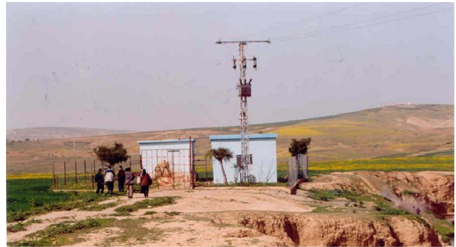
Figure I.6 : Photo de Station de pompage Bouras.
