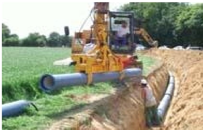
**Figure VI.4.** Pose de conduite dans un terrain ordinaire.
