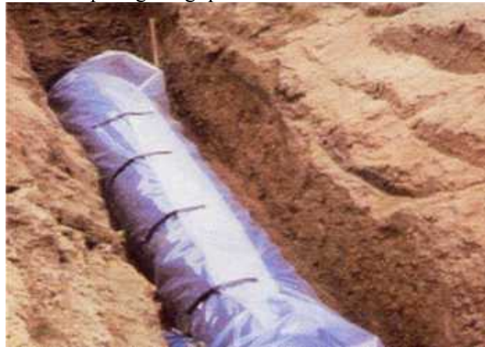
Figure VI-5: Protection contre la corrosion extérieure avec revêtement en polyéthylène
