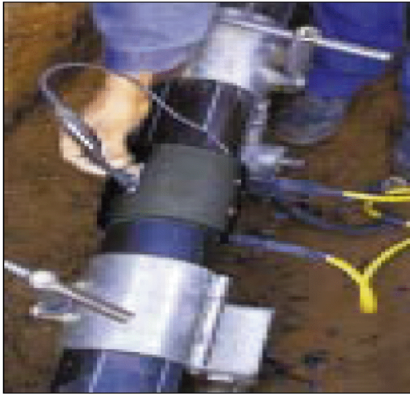
(b) Électrosoudage sur PE
