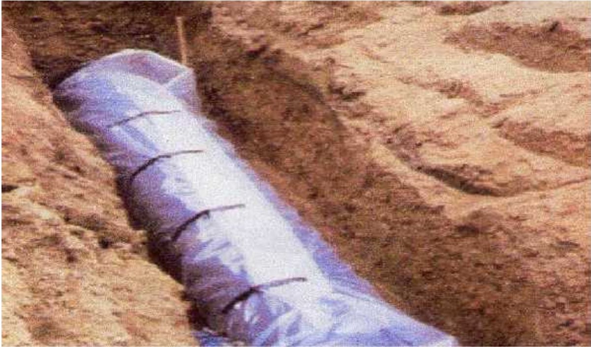
Figure V.1: Installations de tuyaux recouverts d'une protection en polyéthylène
