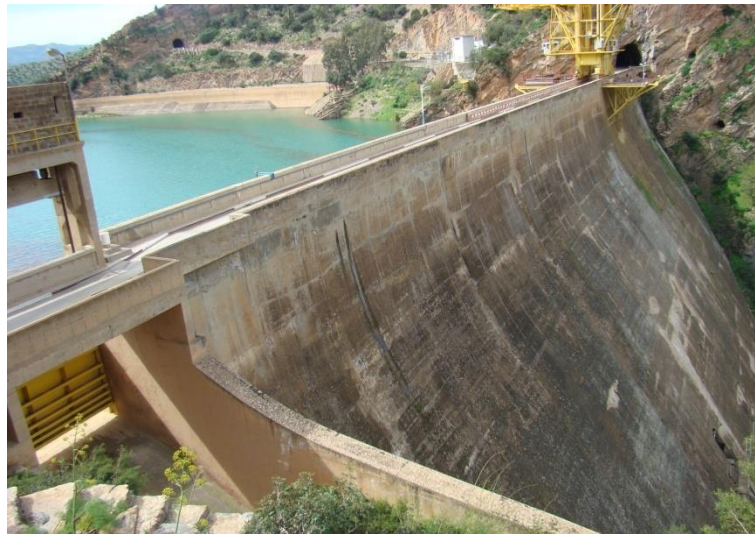
Figure 2.2 : Vue du barrage-poids en Béton d'Oued El Fodda.
