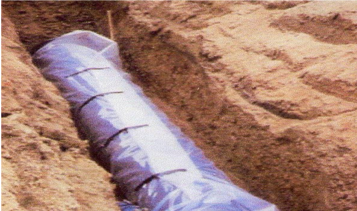
Figure VI.1: Installations de tuyaux recouverts d'une protection en polyéthylène
